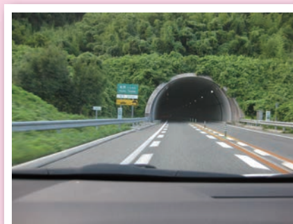
トンネルの出口付近注意
